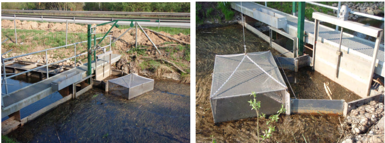
Abb. 6: Kontrollreuse am aquaLEB-Pass an der Stauanlage Rehwinkel (Neue Brookwetterung) [aus: LIMNOBIOS 2011]
