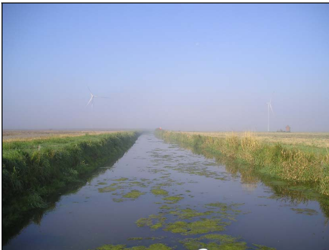
Foto 4: Das Wischhafener Schleusenfleth weist eine gestreckte Linienführung auf.
